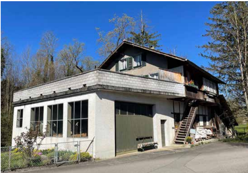
Abb. 7: Kettenschmiede mit Anbau von 1972
