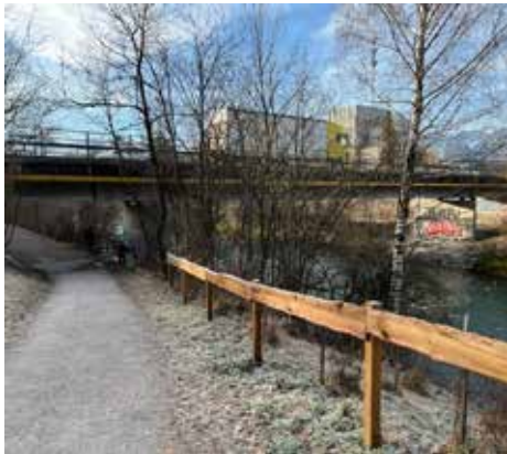
Erneuerung der «ARA-Brücke»
